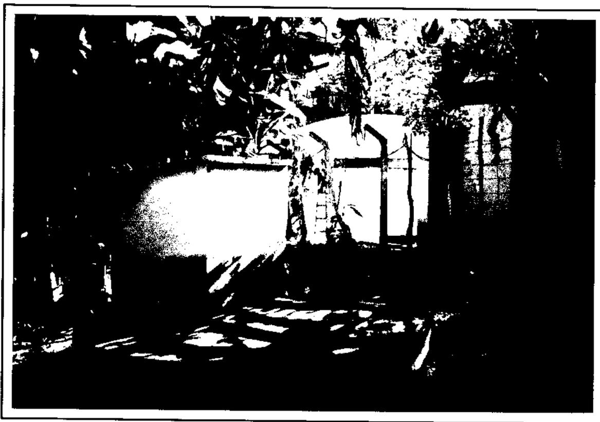
FOTO 21/22 - VISTA DO RESERVATÓRIO DE REUNIÃO QUE RECEBE A VAZÃO DE TRÊS POÇOS E DA ESTAÇÃO ELEVATÓRIA QUE RECALCA A VAZÃO PARA O RESERVATÓRIO ELEVADO AO LADO.
